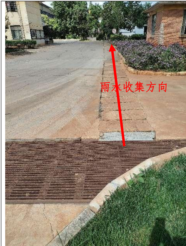
场内雨水收集沟
