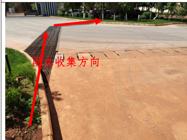
场内雨水收集沟
